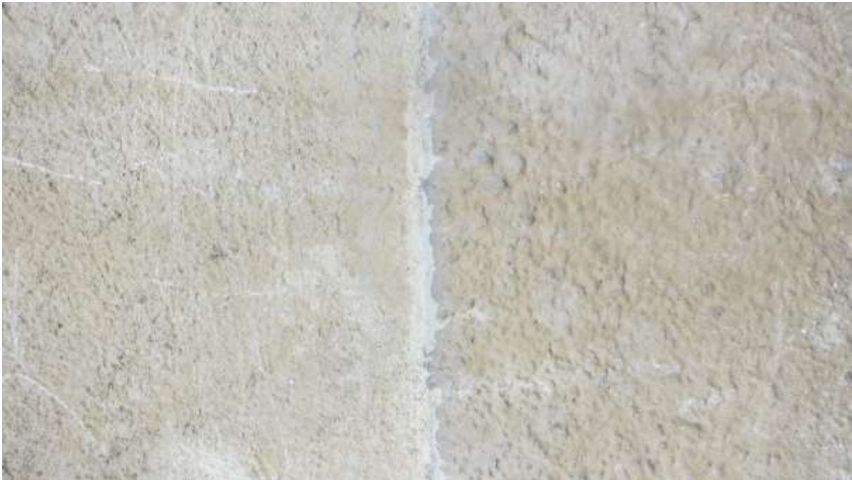
FIGUR 6. DAGENS STRUKTUR I OVERFLATER.: VEGGLIV TIL VENSTRE. SOKKEL TIL HØYRE. (FOTO. MUR OG MER, NOV. 2015)
