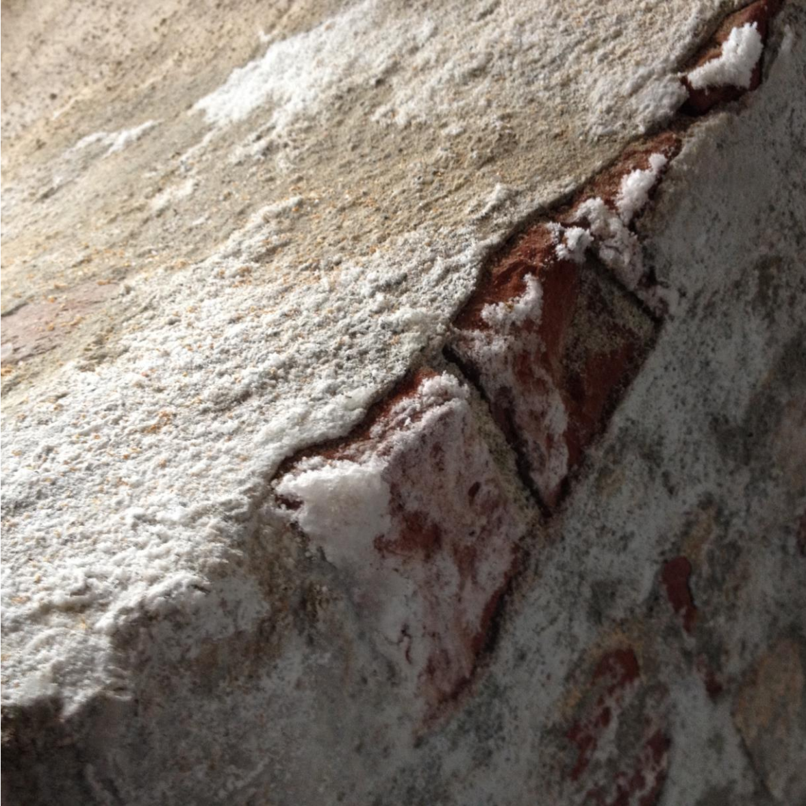
Figur 3. Salter på overflate, innvendige vegger. Tårnets 2. etg. (Foto. Mur og Mer, mai 2015)
